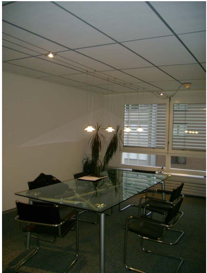
Sitzungszimmer mit der heruntergehängten Decke als raumakustische Massnahme
