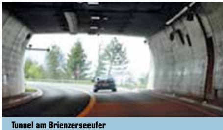
Tunnel am Brienzseeufer
