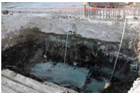
Schichtung des Bodens auf einer Baustelle
