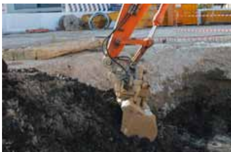
Aushubarbeiten auf einer Baustelle
