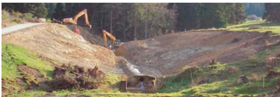
Ansicht der Aushubbaustelle. Das ehemalige Tal ist deutlich ersichtlich. In der Mitte ist der kanalisierte Bach erkennbar.
