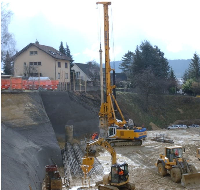
oben: Baustelle mit Hangsicherung
