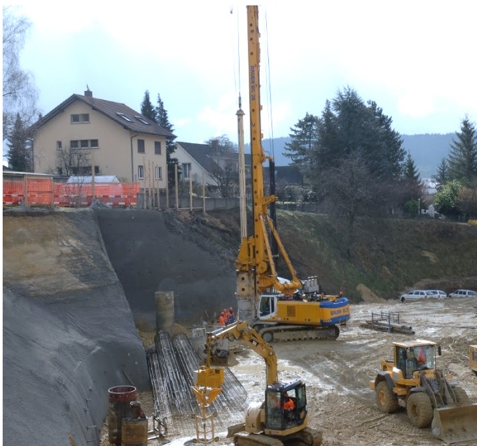
en haut: Chantier avec sécurisation de la pente
