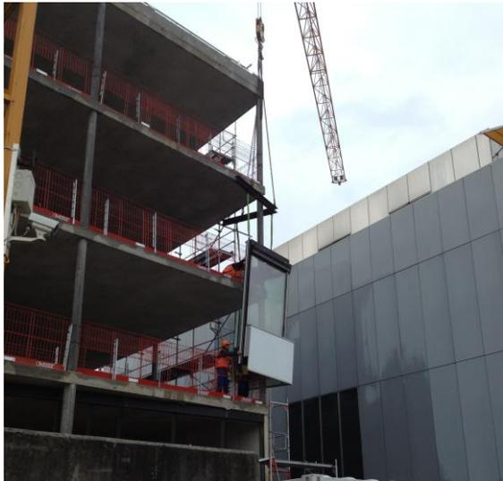
Montage eines Fassadenelements ohne Gerüst
