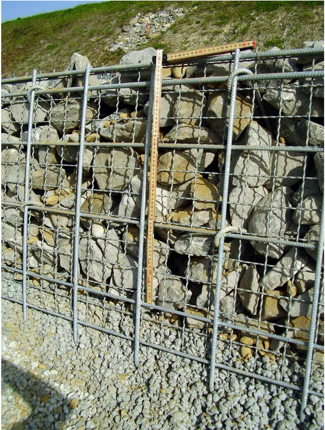
System Rüglei modifiziert für Reptilien . Die grössere Maschenweite und die Hinterfüllung mit Schroppen oder Bruchsteinen ist eine echte Chance für Reptilien und sollte standardmässig eingesetzt werden!
